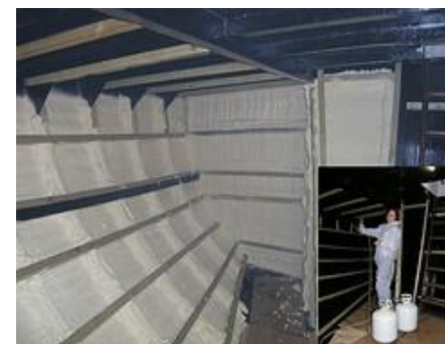
Aislamiento térmico sección popa
