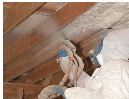
Aplicación de espuma de poliuretano
