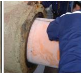
Ilustración 15. Colocación de bocín.
