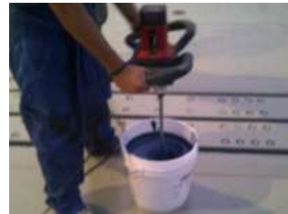
Mezcla de componentes previa a su aplicación
