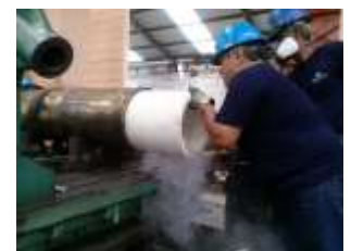
Instalación del bocín en el alojamiento de bronce
