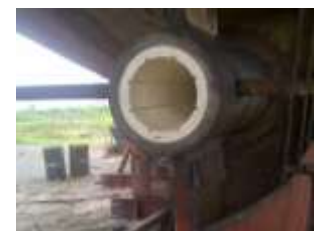
Bocín finalmente instalado en el túnel
